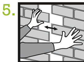
Encajar el siguiente panel hasta que desborde la masilla
